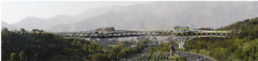
پل طبیعت - بزرگراه مدرس (بین بزرگراه حقانی و بزرگراه همت) - در حال ساخت
