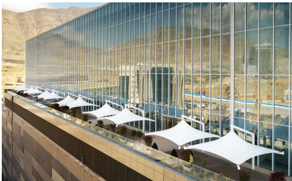
▲ سایبان‌های تراس نمایشگاه بازار بزرگ ایران، تهران، ۱۳۹۷ ▲ Membrane Canopies of Iran Mall Exhibitions Building-Tehran-2018
